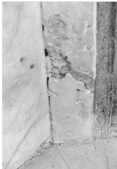
شکل ۲- نمایش خوردگی سطحی سنگ مرمر در اثر تاثیر محلول‌های واکنش‌زای موجود در رطوبت محیط
