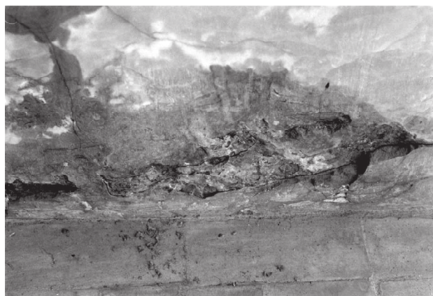
شکل ۱- نمایش هوازدگی سطحی و عمقی سنگ مرمر به دلیل نفوذ رطوبت محیطی
