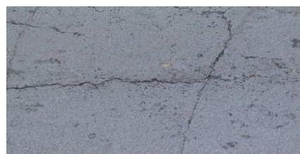
شکل ۱۱- نمایی از ترک‌های ایجاد شده بر پوشش فتوکاتالیستی اعمال شده بر روی آسفالت خیابان در ایتالیا [۳]
