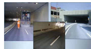
شکل ۱۳- نمایی از پوشش های بتنی فتوکاتالیستی در مونزا [۳]
