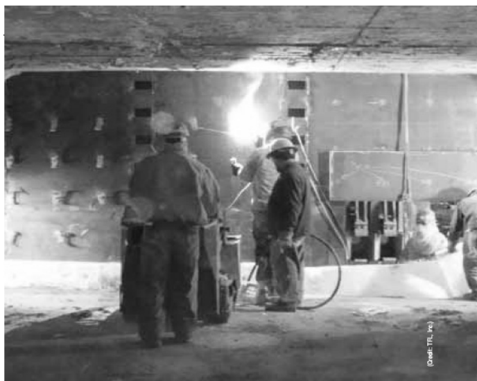
شکل ۵- سقف یک کوره گرمایش مجدد فولاد با ابعاد ۵۰ × ۳۰ فوت که توسط آجرهای پیش ساخته و پیش گرم شده دیرگداز ترمیم شده است
